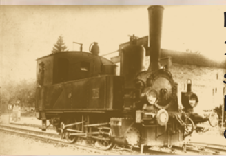
Erste Lok, zweiachsig, 1895 bei Vulcan in Stettin gebaut
